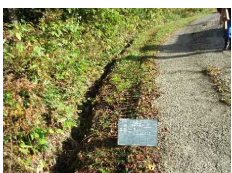
【施工前の水路状況】
