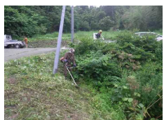
【水路法面の草刈】
