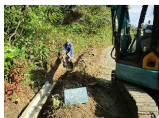
【水路の更新作業】
