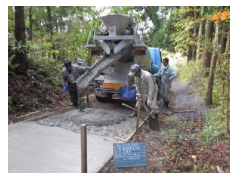
【農道の舗装作業】
